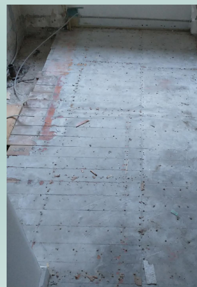
Eksisterende gulv Hvor der har ligget linoleum
